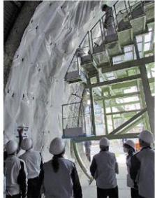
を共同で進めている。モデルセンターには大林組が独自開発したセントル自動セツシステムも搭載。トンネル覆工作業で最も人員を要するセントルセツ作業がスイッチ一つ、約10分で自動的に完了する。測量機械やパソコンなどパッケージ化した設備類を施工中の現場にも後付けでき、セントルメーカを問わず、ゼネコンの制約を受けずに導入可能だ。五洋建設と開発した防水シート自動溶着器は、シート台車に搭載した。従来方法では2人必要だったが、1人で作業できるという。小林社長は先月27日の見学会で「実際に見て、触って当社の技術を肌で感じてもらいたい」とあいさつ。ゼネコン各社にも模擬トンネルとモデルセンターを研究開発の場に活用してもらい、「新技術の開発スピードを加速させたい」と意気込みを語った。
